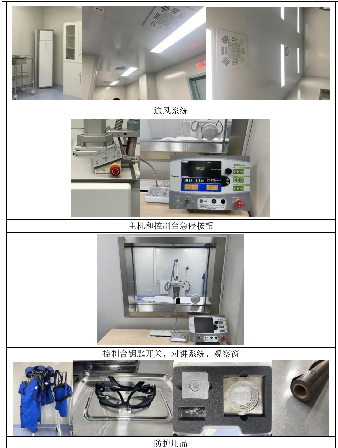
图 3-2 平房区 X 射线浅部治疗室配备的相关防护措施现场照片
